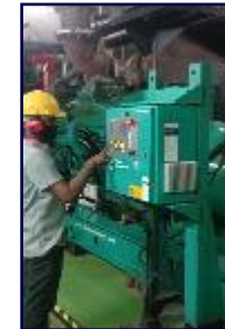
DG Parameters Checking
